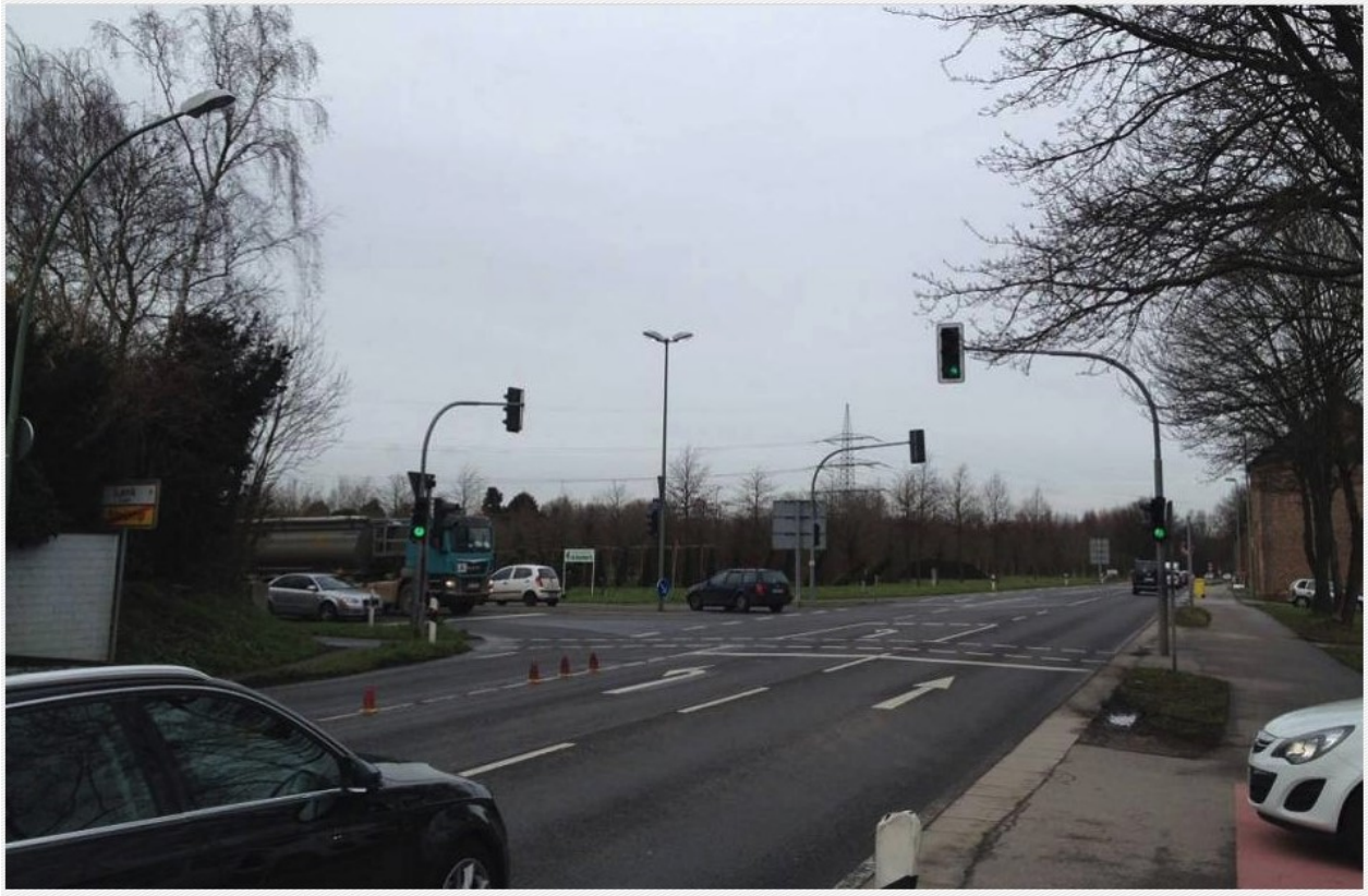
Die Kreuzung Xantener Straße/Schlossstraße soll sicherer werden. Straßen.NRW will eine neue Ampel bauen.
