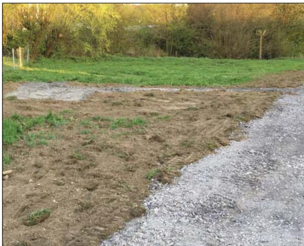
Der Untergrund des Weges ist fertig, jetzt folgt die Deckschicht und dann ist diese Arbeit erledigt.
